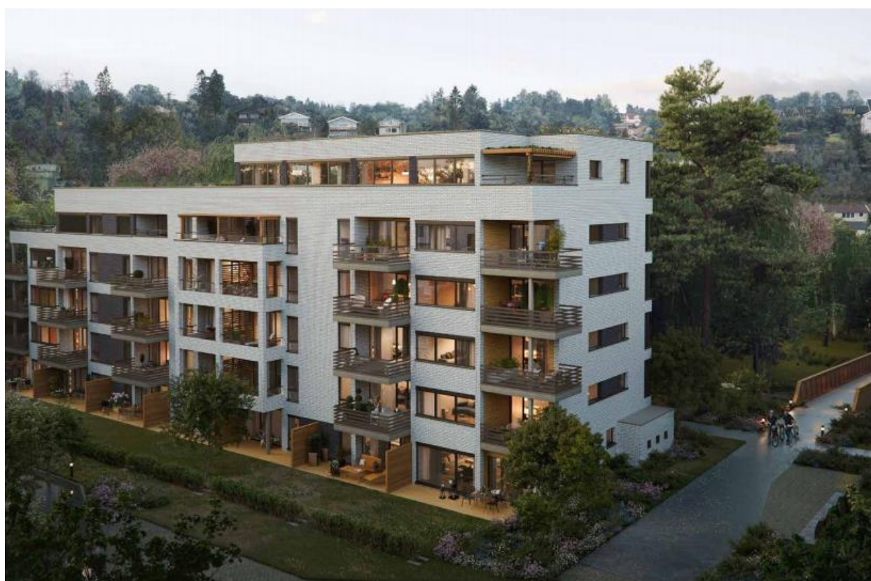
Neselva Hageby byggetrinn 2, Alento
